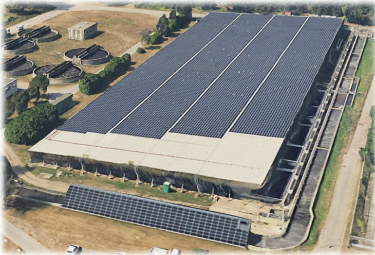
Foto area dell'impianto di Lonate Pozzolo post-intervento
